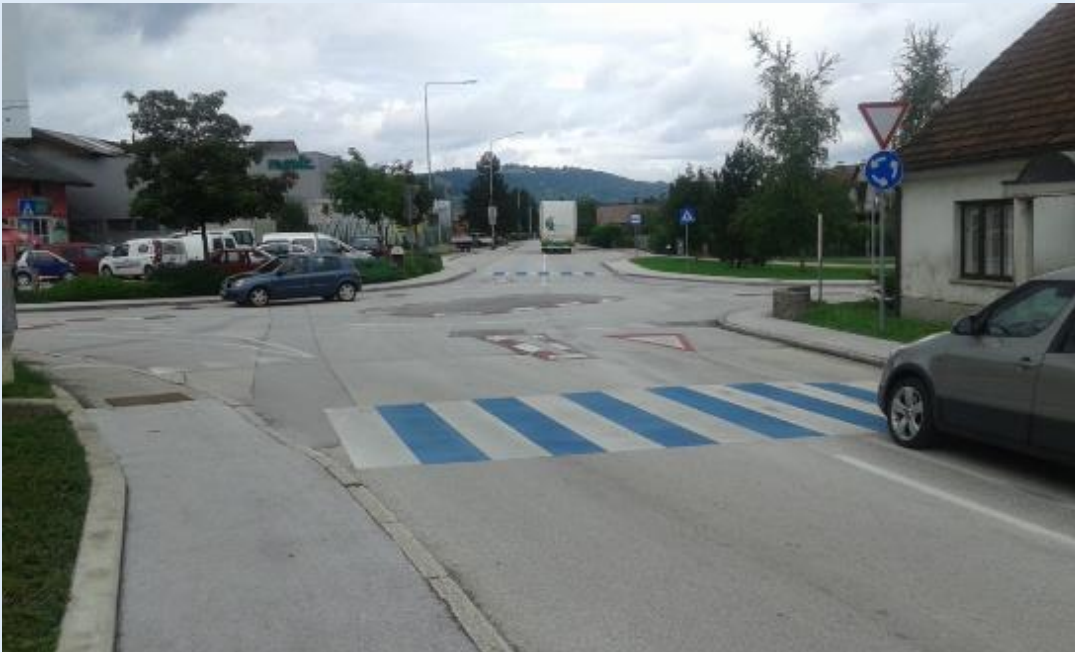
Slika: Križišče Ulice 11. novembra – Ulice MDB in Pot na Beli breg. Križišče je nevarno za prehajanje pešcev preko vozišča. Urejeno je kot krožišče in na srečo opremljeno s prehodi za pešce ter pločniki, s čimer je zmanjšano tveganje za nesreče v katerih bi bili udeleženi pešci.
